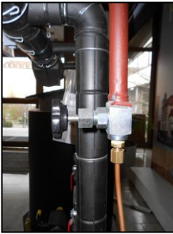
Abb. 3: Nadeldrosselventil
